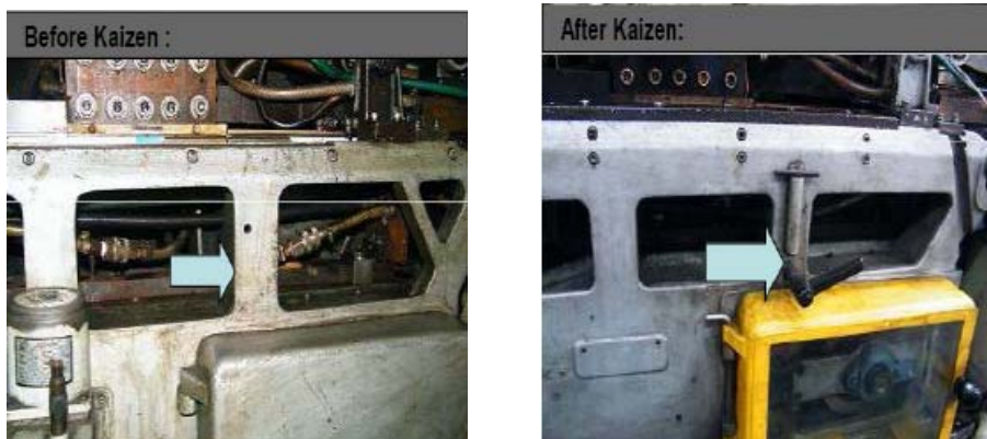
รูปที่ 3-22 ก่อนและหลังการปรับปรุงการถอดไกร์แดน
