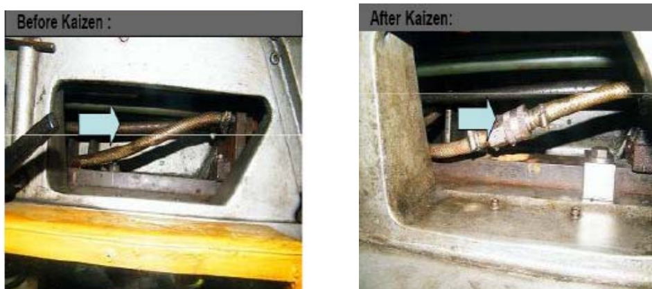
รูปที่ 3-23 ก่อนและหลังการปรับปรุงการต่อสายน้ำหล่อเย็น
